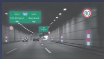
安全標識等 (道路の誘導ポール・料金所・駐車場)
